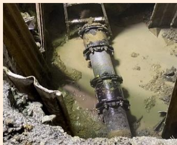
水道管(配水管)の漏水を修繕している状況
