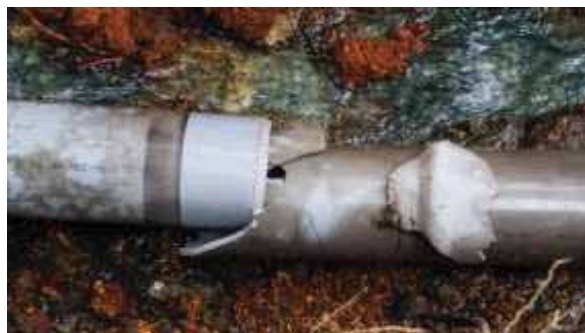
φ150 硬質塩化ビニル管 (RR継手)破損状況
