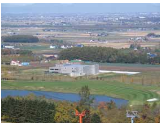
災害時活動拠点（第1浄水場）
