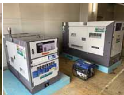
可搬式非常用発電機
