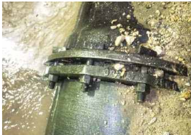
ダクタイル鋳鉄管(K形)の継手抜け
