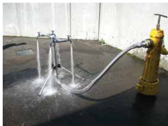
仮設給水栓セット
